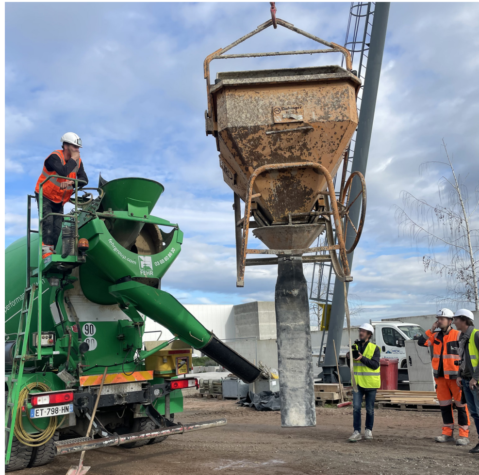
Outils du béton de ciment réemployés pour le béton d'argile - usine FEHR, Achern, Allemagne ©nm architecte
