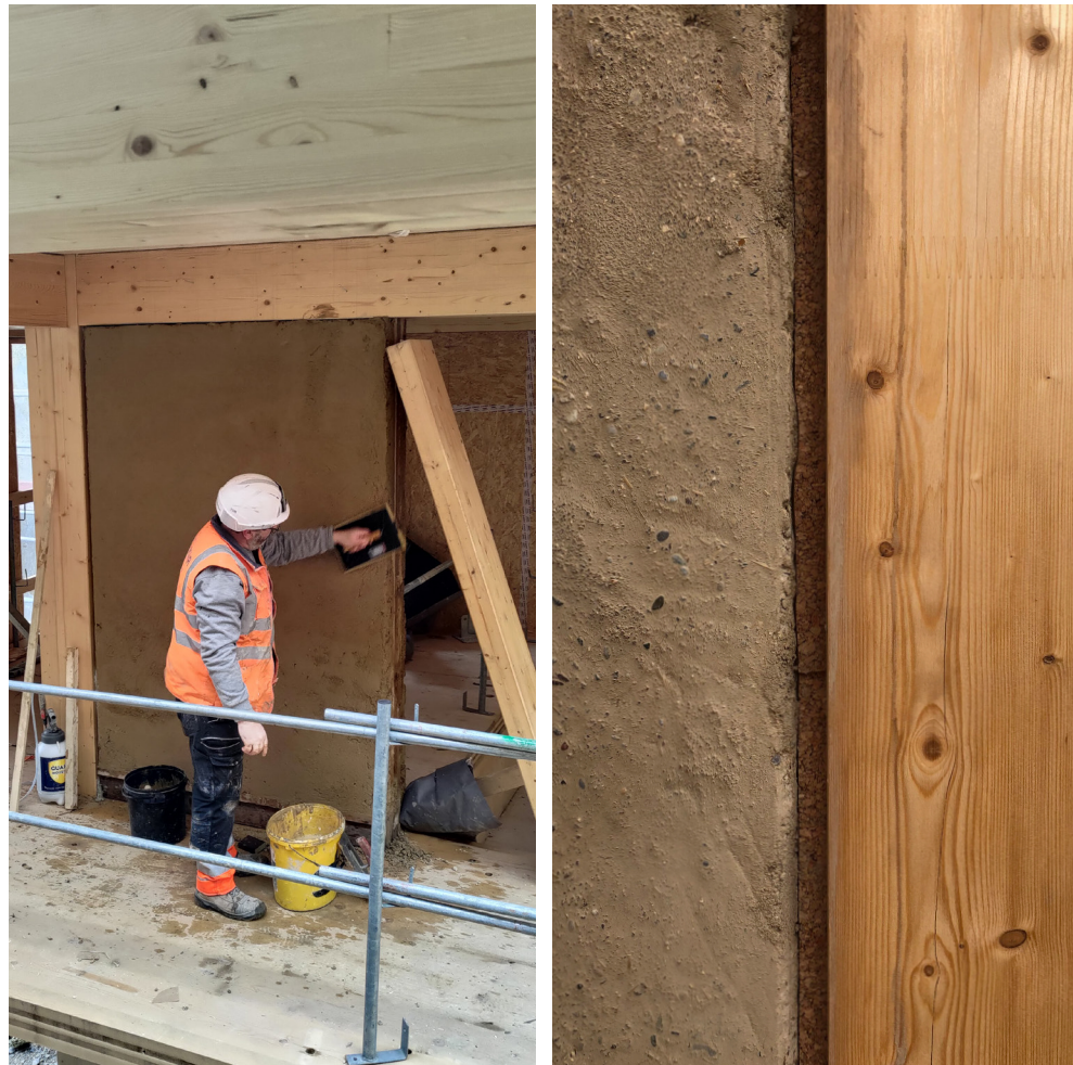
Première reprise de surface en cours sur un mur en terre crue coulée (à gauche) ; Interface mur en terre/poteau bois traitée par une lamelle de plaque de liège (à droite) - médiathèque James Baldwin, Paris 19e ©nm architecte
