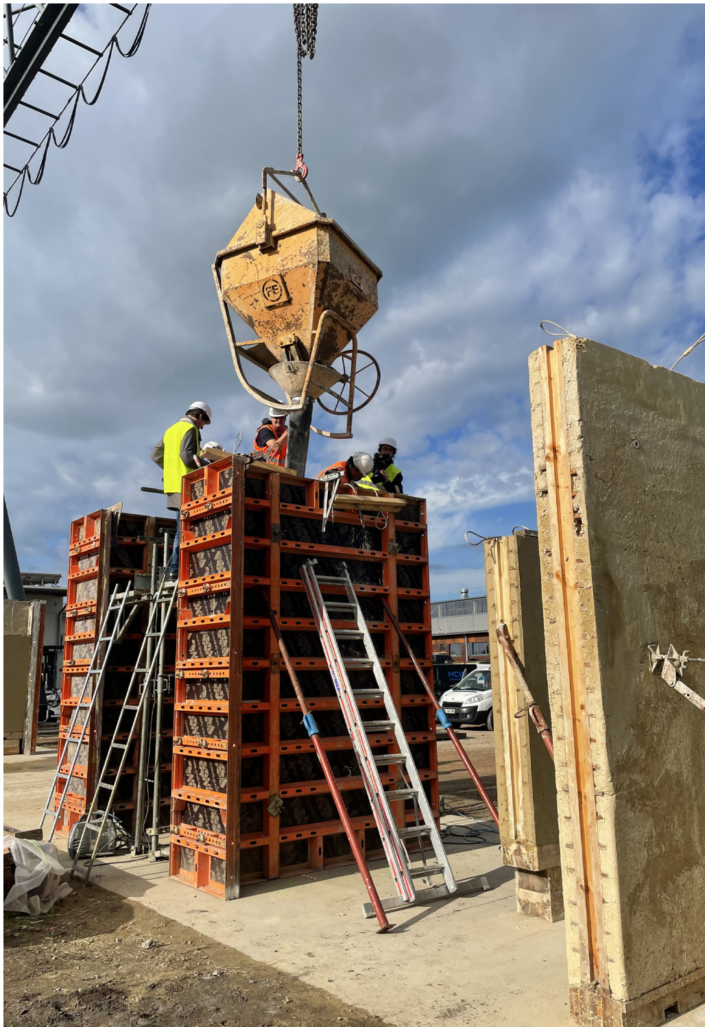
Béton d'argile coulé dans des coffrages de béton de ciment - usine FEHR, Achern, Allemagne ©nm architecte
