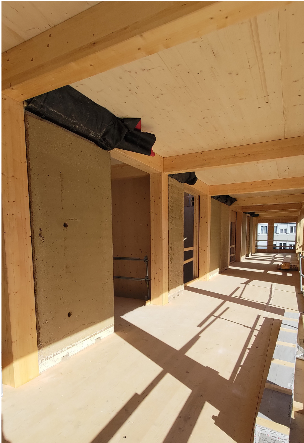
Murs en terre crue coulée posés au niveau R+2 - médiathèque James Baldwin, Paris 19e ©nm architecte
